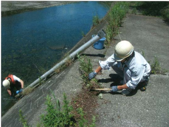
St. 1 (三崎川河口) 周辺草刈状況
