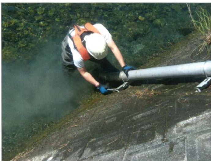
St. 1 (三崎川河口) センサー保護管点検状況
