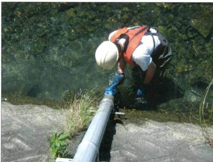
St. 1 (三崎川河口) センサー保護管清掃状況
