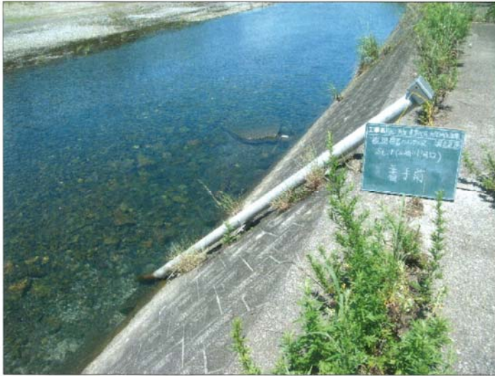
St. 1 (三崎川河口) 点検前
