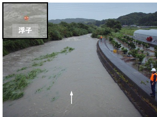
浮子による流量観測（洪水時）
