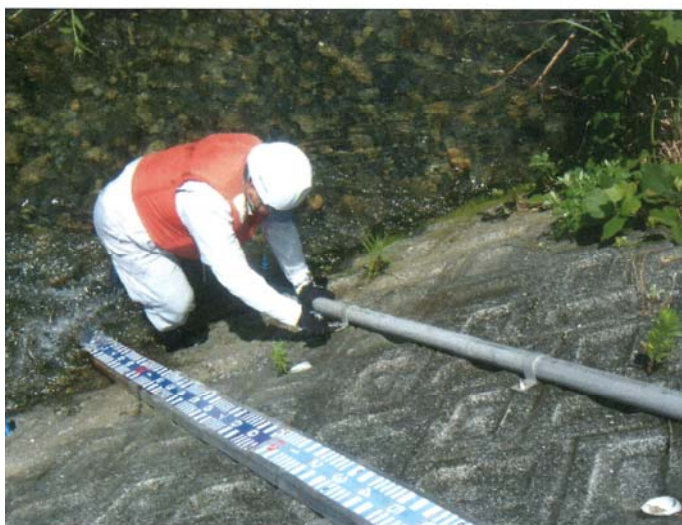
St. 2 (三崎川) センサー保護管点検状況
