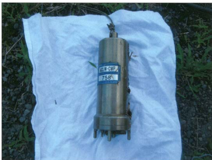
St. 1 (三崎川河口) 濁度計 センサー点検前
