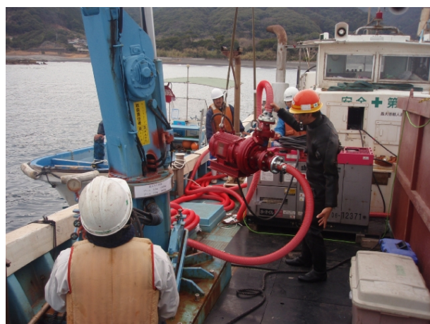
写真 4-3-14 横型サンドポンプ設置状況
