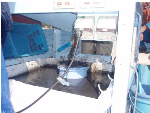
写真 4-3-26 小型排水処理装置 排出状況
