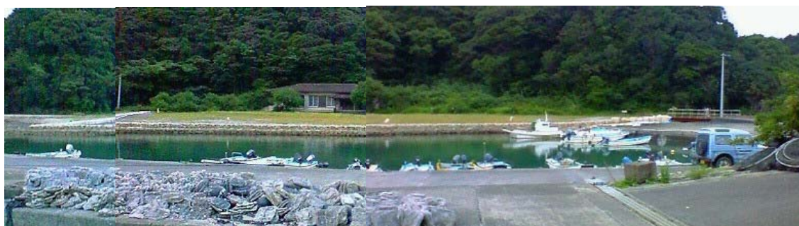
写真 4-5-2 水処理ヤード予定地点 全景
