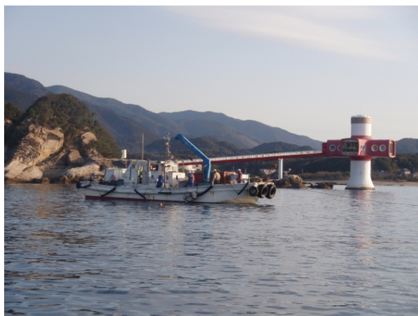
写真 4-3-15 実証試験作業状況
