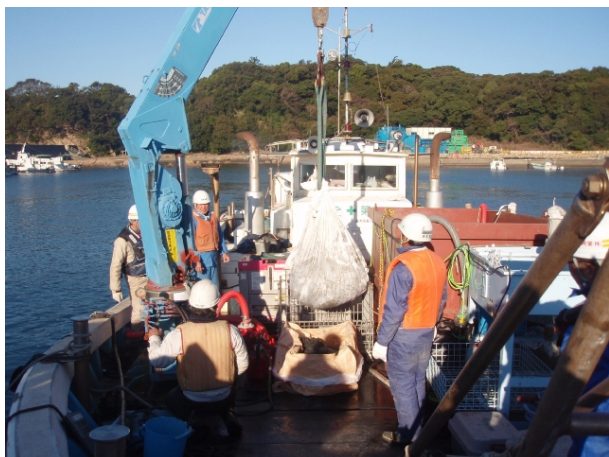
写真 4-3-30 排出土陸揚げ状況
