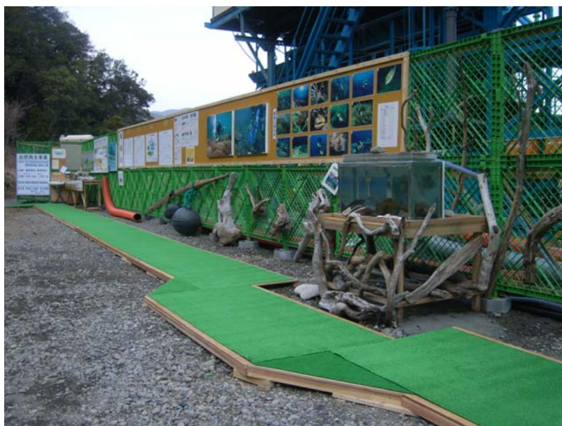
写真 4-5-4 バリケードフェンス及び工事見学路
