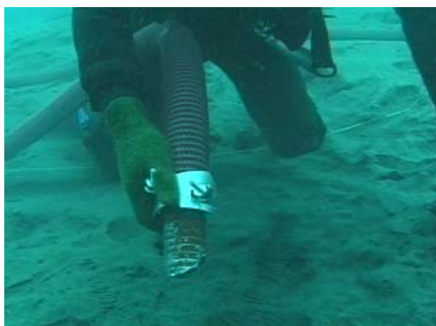
写真 4-3-16 泥土除去作業状況
