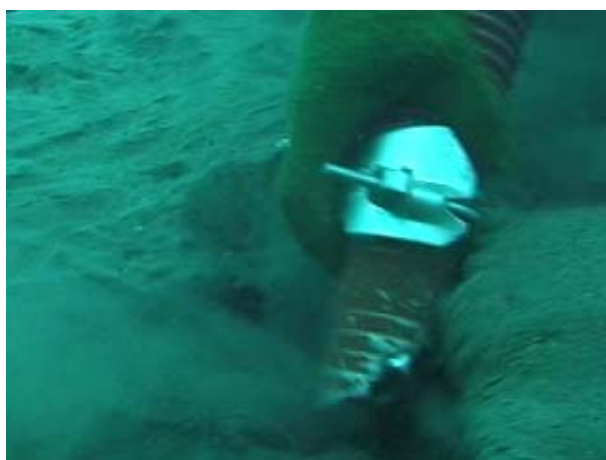
写真 4-3-17 泥土除去作業状況
