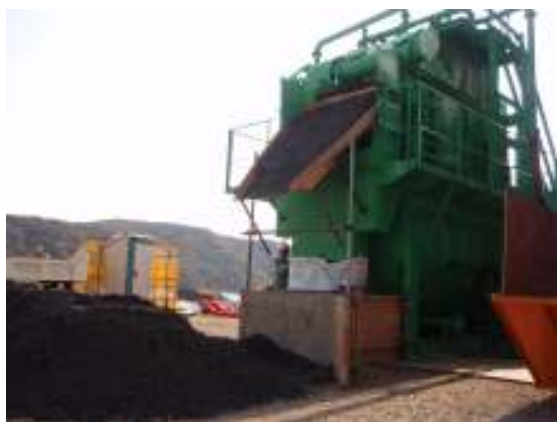
写真 2-6-9 砂分 [平成 21 年 2 月 18 日（稼働 3hr 後）]
