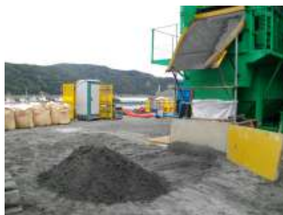
写真 2-6-10 砂分 [平成 21 年 3 月 2 日（稼働 6hr 後）]
