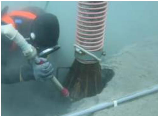
写真 2-7-5 泥土除去作業状況（吸込み口）
