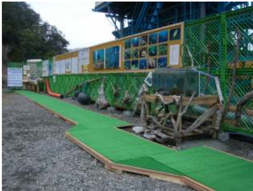
写真 2-10-4 バリケードフェンス及び工事見学路
