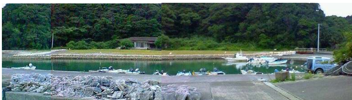
写真 2-10-2 水処理ヤード予定地点 全景
