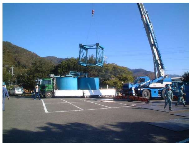
写真 3-6-4 水処理装置設置状況
