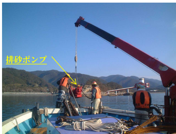
写真2-5-2 排砂ポンプ投入状況
