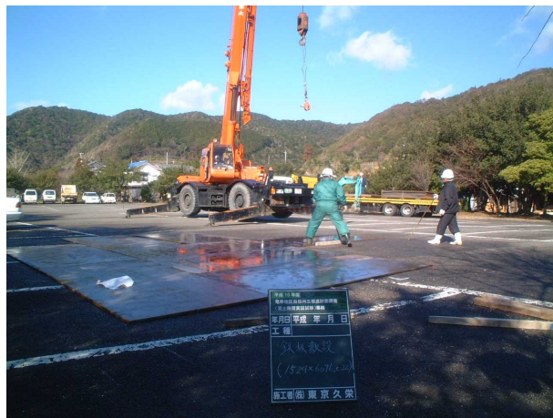
写真 3-6-2 基礎鉄板設置状況
