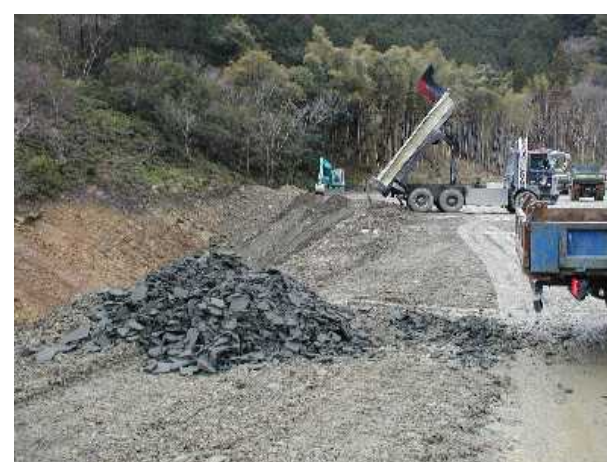
写真 3-6-35 発生土の埋立状況
