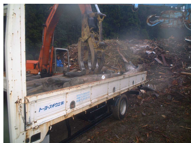
写真 4-3-12 沈木処分状況
