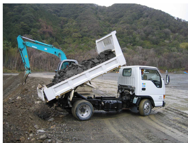
写真 3-6-34 発生土の埋立状況
