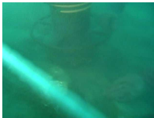
写真 2-5-8 浚渫状況（従来型）
