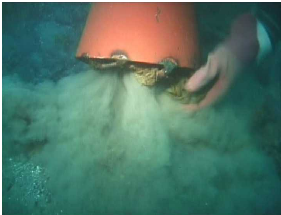
写真 2-5-41 ジェット併用Ⅱ型浚渫状況
