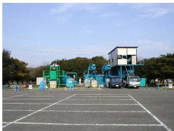
写真 3-6-5 水処理設備設置状況
