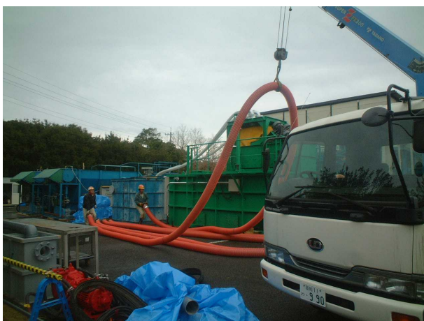
写真2-6-5 仮設配管敷設状況（陸上部）
