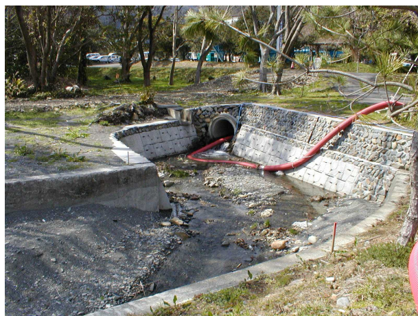
写真2-6-6 仮設配管道路横断面部
