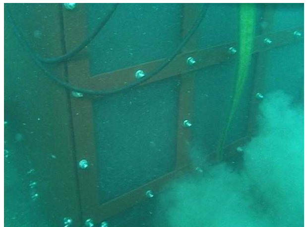
写真 2-5-15 浚渫状況（ジェット併用Ⅰ型）
