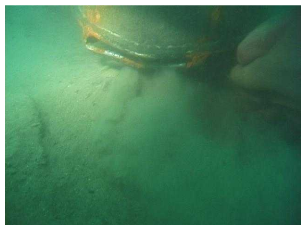
写真 2-3-11 浚渫状況（従来型）
