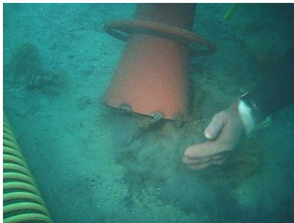
写真 2-5-20 浚渫状況（ジェット併用Ⅱ型）
