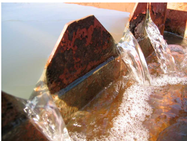
写真 3-6-22 シックナー処理状況
