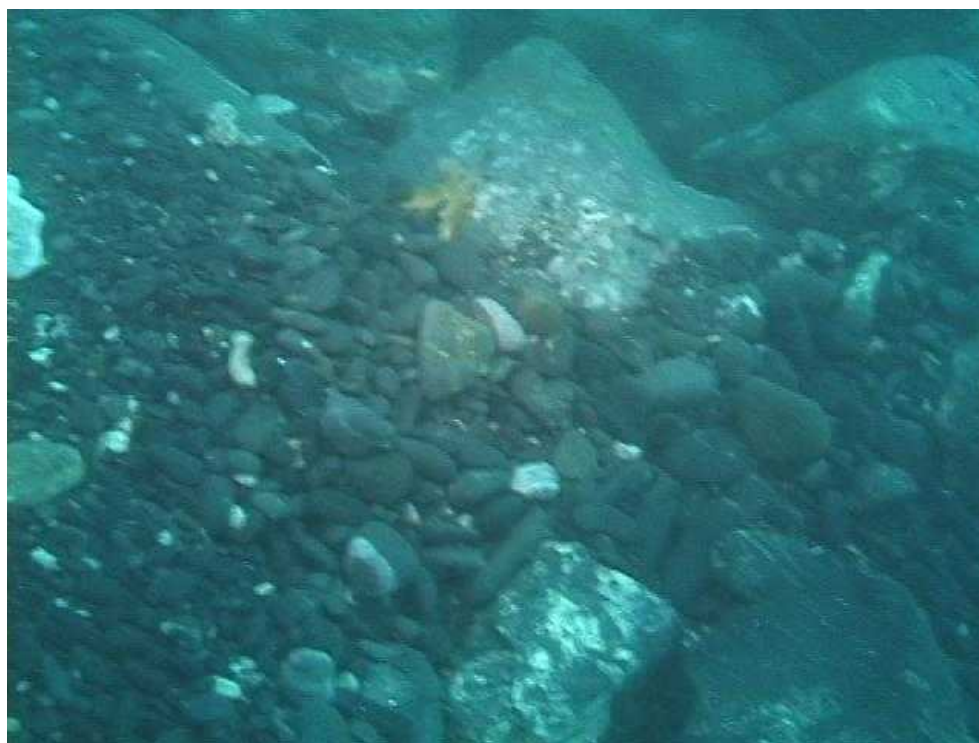
写真 2-5-33 浚渫後の改定状況
