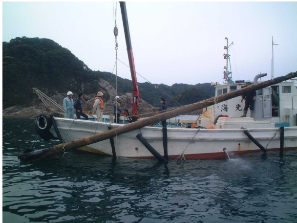
写真 4-3-7 沈木回収状況
