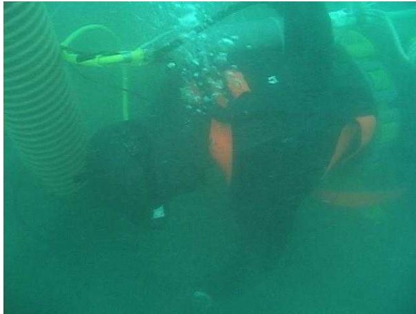
写真 2-5-6 浚渫状況（従来型）
