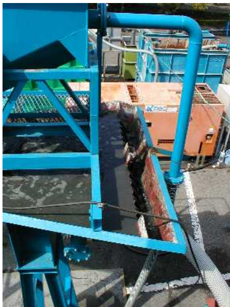
写真 3-6-10 処理状況（スパイラル分級機）
