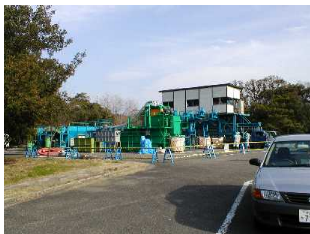
写真 3-6-6 水処理設備設置状況
