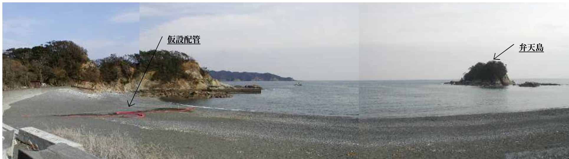
写真 1-5-1 浚渫試験海域
