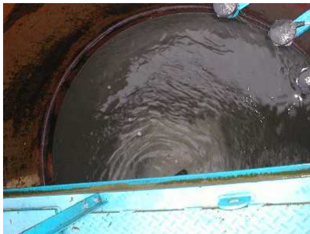
写真 3-6-25 汚泥（スラリー）貯留状況
