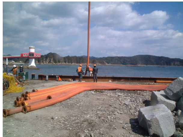
写真2-6-4 仮設配管布設状況
