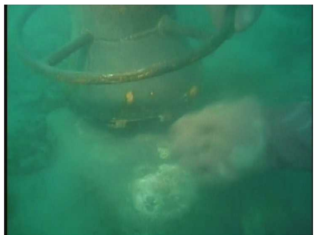
写真 2-5-9 浚渫状況（従来型）
