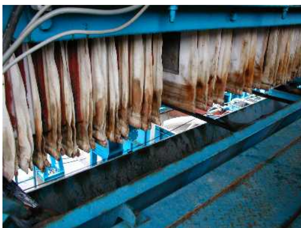
写真 3-6-28 開削状況（脱水機）
