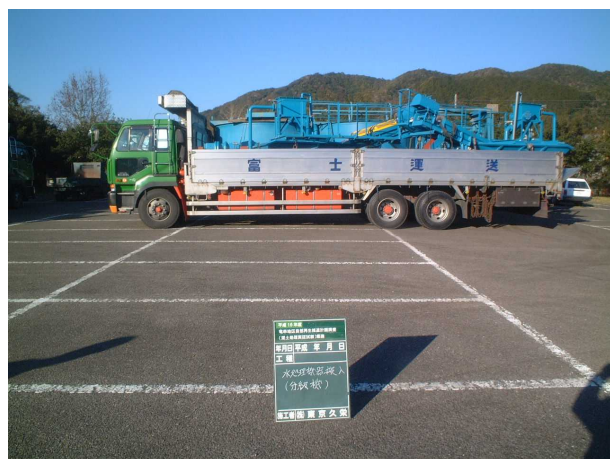
写真 3-6-3 水処理装置搬入状況
