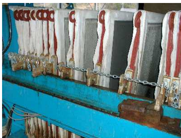
写真 3-6-29 開削状況（脱水機）
