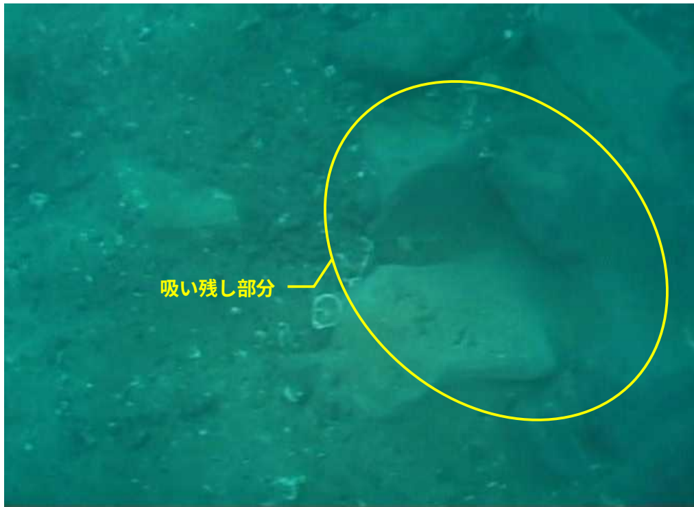
写真 2-5-36 海底状況（泥土の吸い残り）
