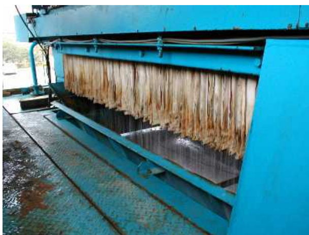
写真 3-6-26 圧入状況（脱水機）
