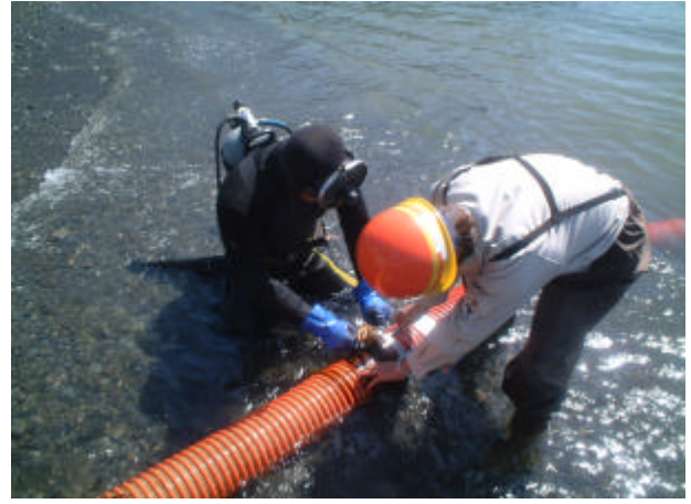
写真 2-4-17 仮設配管布設状況 (ジョイント部)
