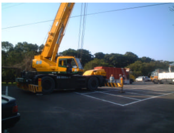
写真 3-8-2 45t 吊ラフタークレーン
