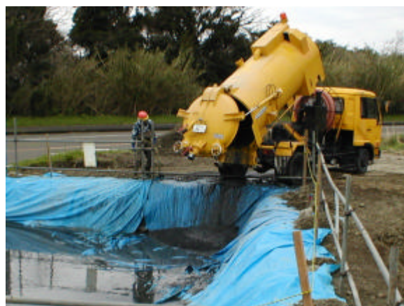
写真 3-7-2 仮置き場への土砂排出
