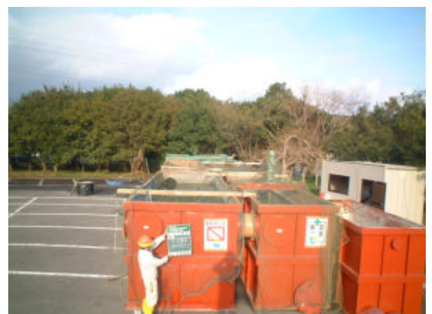
写真 3-8-10 仮設水槽設置状況 (ネットによる水槽開口部の養生)
