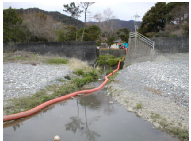
写真 2-4-8 仮設配管布設状況
