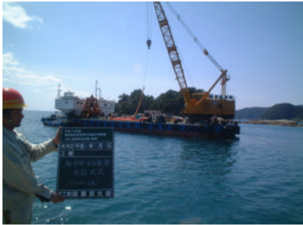
写真 2-4-18 仮設配管布設状況
