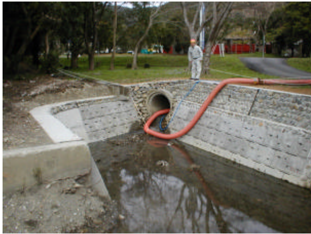
写真 2-4-5 仮設配管布設状況
