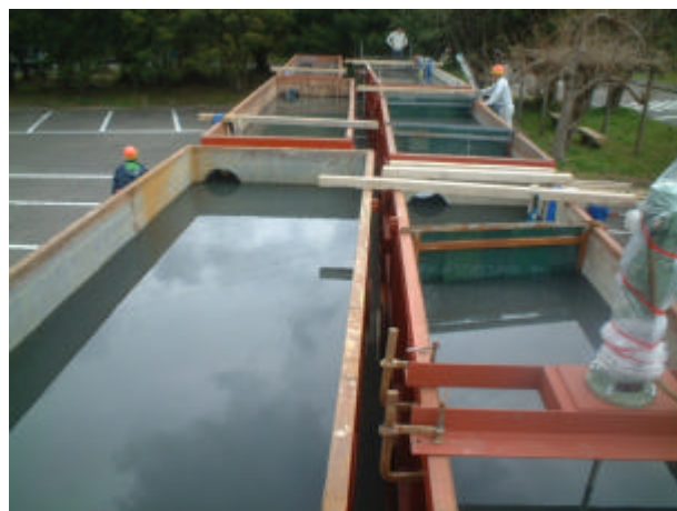
写真 3-5-12 浚渫排水の流入状況
