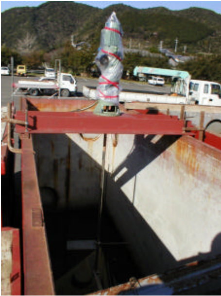
写真 3-8-11 攪拌機設置状況
