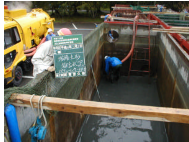
写真 3-5-34 堆積土砂排出状況
