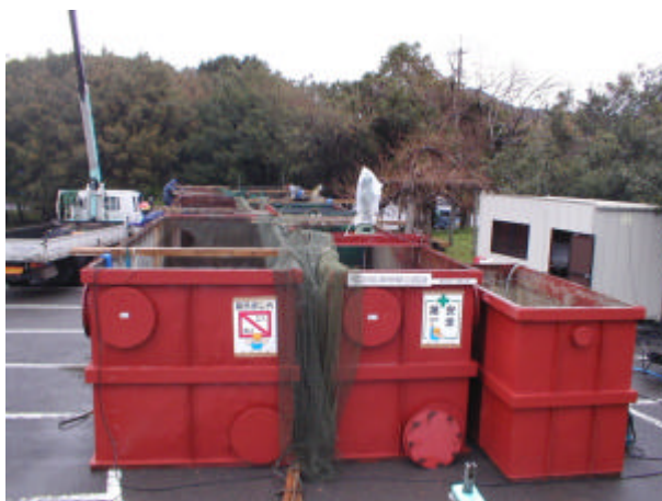
写真 3-5-2 仮設水槽設置状況
