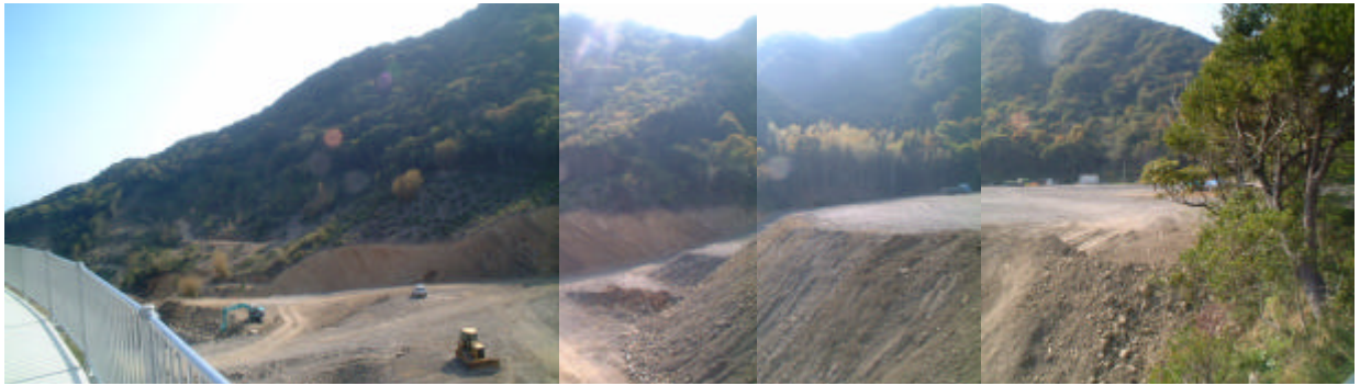
写真 3-7-5 建設残土処分場（残土受入地）
