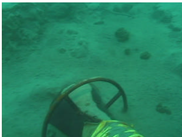
写真 2-3-11 海底状況（浚渫後）
