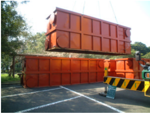
写真 3-8-5 仮設水槽設置状況
