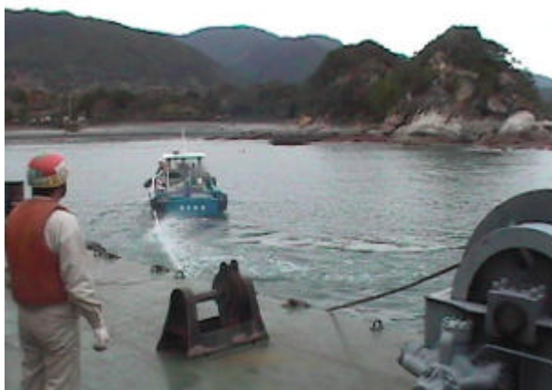
写真 2-3-1 アンカーリング作業
