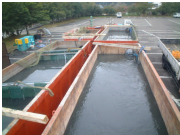
写真 3-5-11 浚渫排水の流入状況
