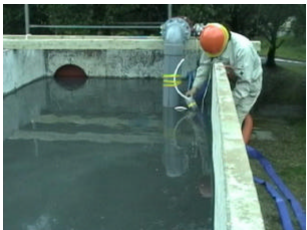
写真 2-3-10 浚渫排水サンプリング
