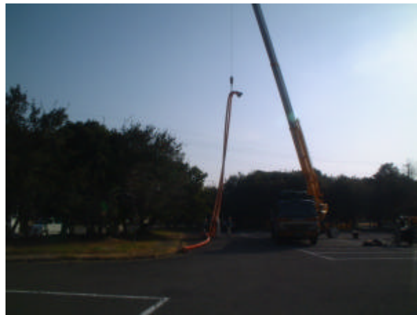
写真 2-4-2 仮設配管仮置き
