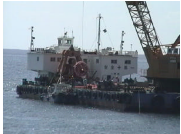
写真 2-4-12 揚錨船へ積み込み
