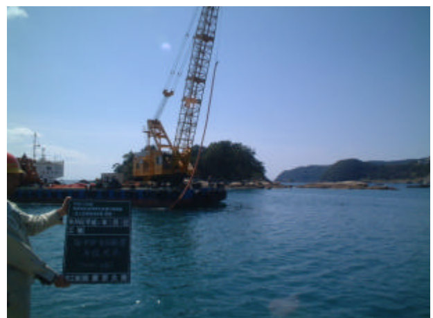
写真 2-4-21 仮設配管撤去状況
