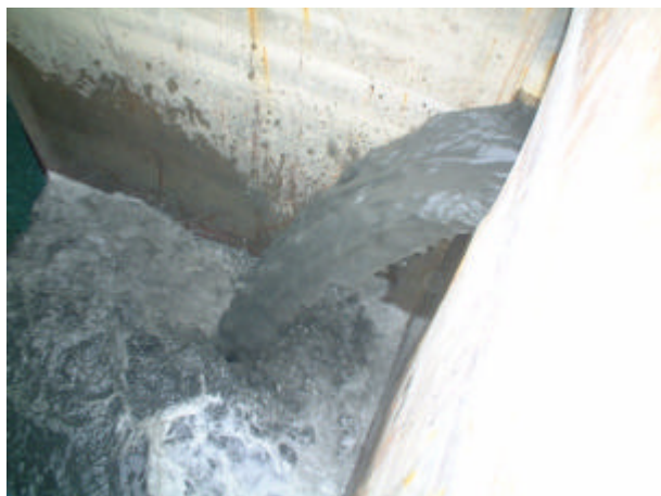
写真 3-5-7 浚渫排水の流入状況
