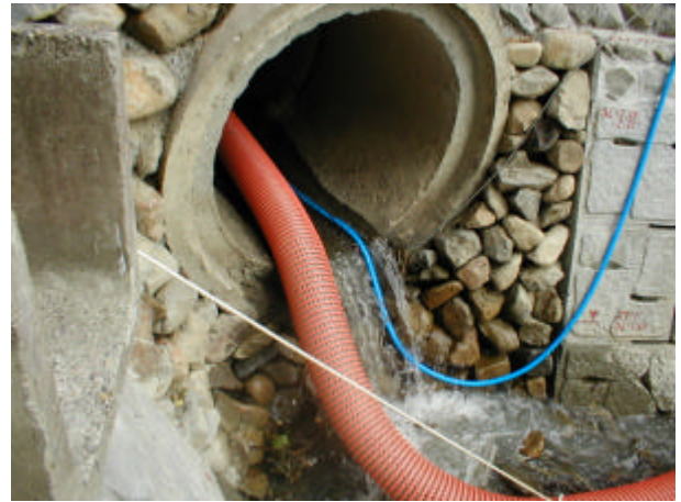
写真 2-4-6 暗渠（パイプカルバート）部
