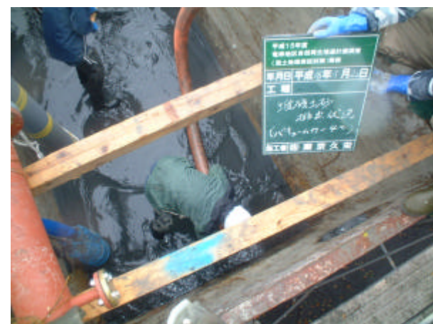
写真 3-5-36 堆積土砂排出状況
