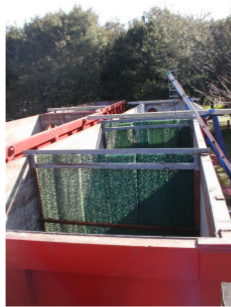
写真 3-8-12 整流板設置状況
