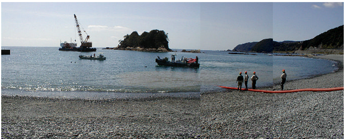
写真 2-4-15 仮設配管布設状況
