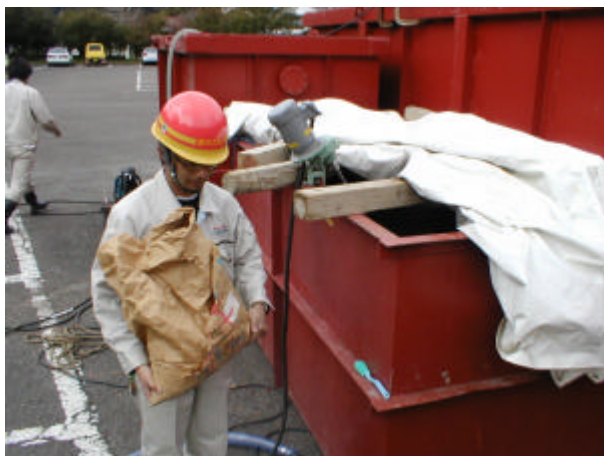
写真 3-5-14 高分子凝集剤 (凝集剤溶解槽)
