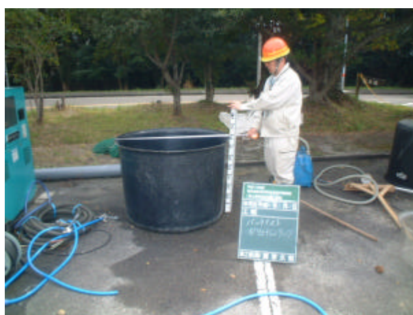
写真 3-8-26 ポリエチレン水槽
