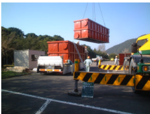
写真 3-8-4 仮設水槽設置状況
