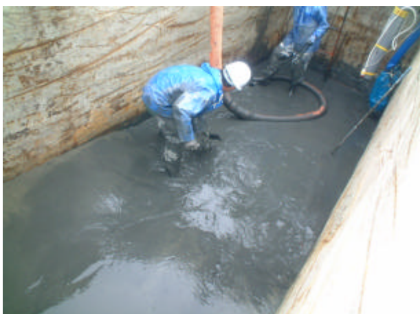
写真 3-5-35 堆積土砂排出状況
