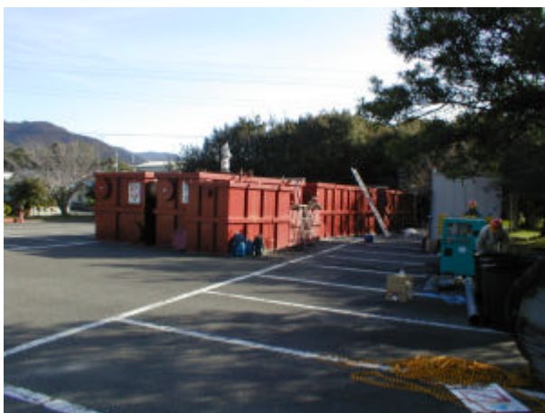
写真 3-8-9 仮設水槽設置状況
