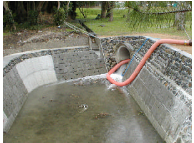
写真 3-5-26 排水状況 (井出口川暗渠部)
