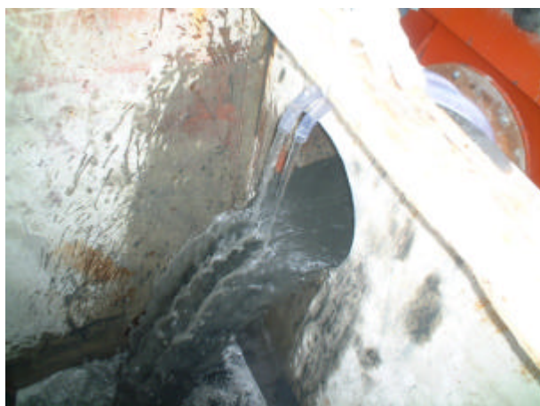
写真 3-5-17 高分子凝集剤注入状況
