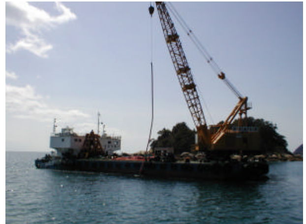
写真 2-4-19 仮設配管布設状況
