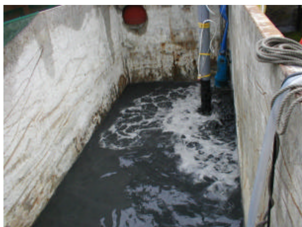
写真 3-5-3 浚渫排水の流入状況
