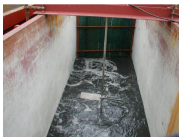
写真 3-5-6 浚渫排水の流入状況
