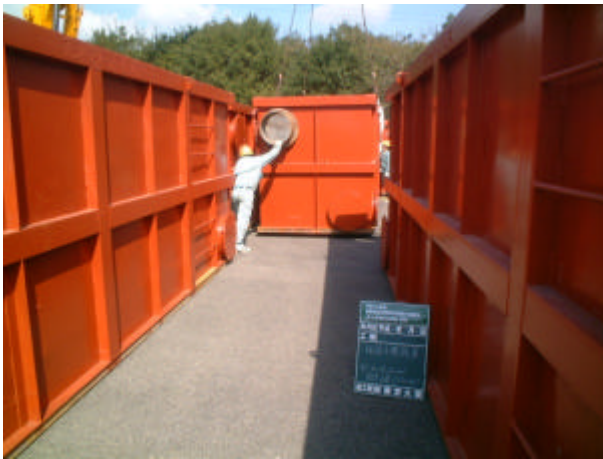
写真 3-8-7 仮設水槽設置状況
