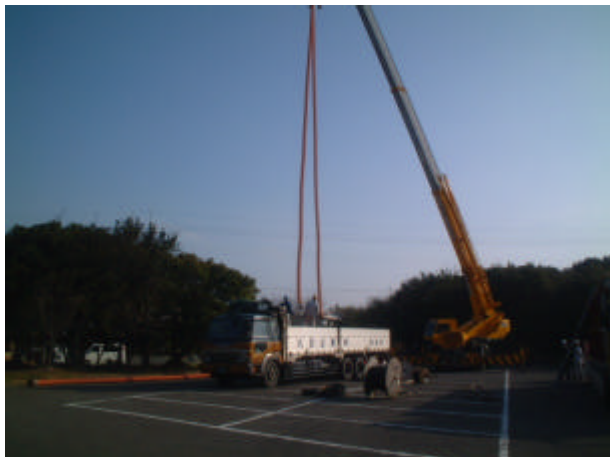
写真 2-4-1 仮設配管搬入
