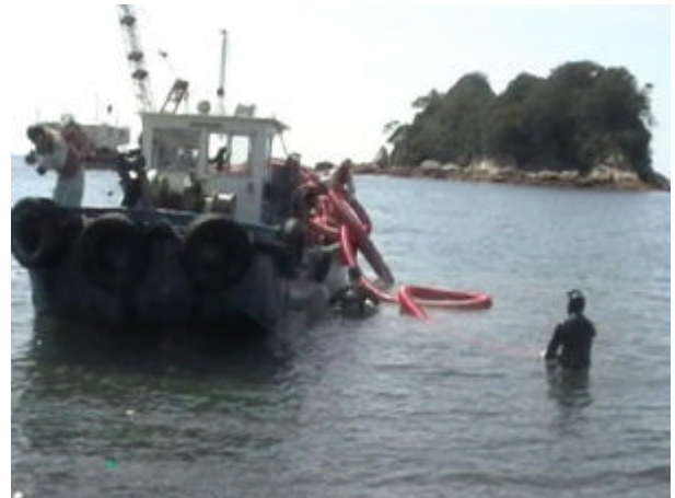
写真 2-4-14 仮設配管布設状況
