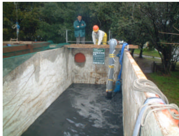
写真 3-5-4 浚渫排水の流入状況
