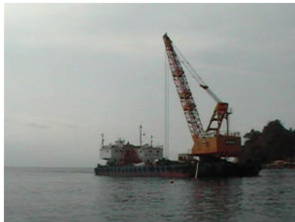
写真 2-3-2 120t 吊クレーン付台船
