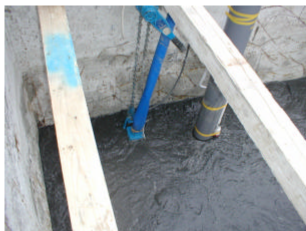
写真 3-5-5 浚渫排水の流入状況
