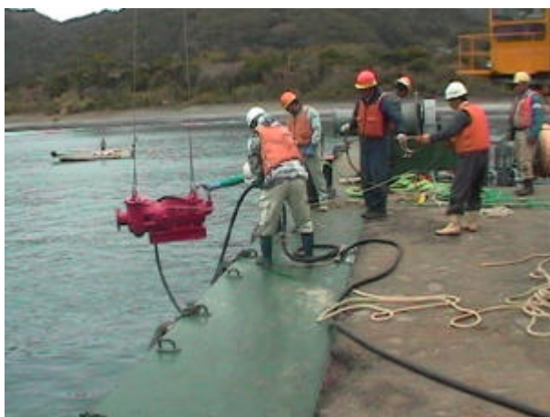
写真 2-3-5 排砂ポンプ投入
