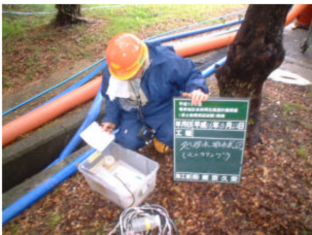
写真 3-5-29 排水濁度の測定状況
