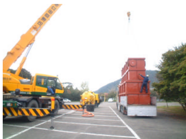
写真 3-8-16 仮設水槽撤去
