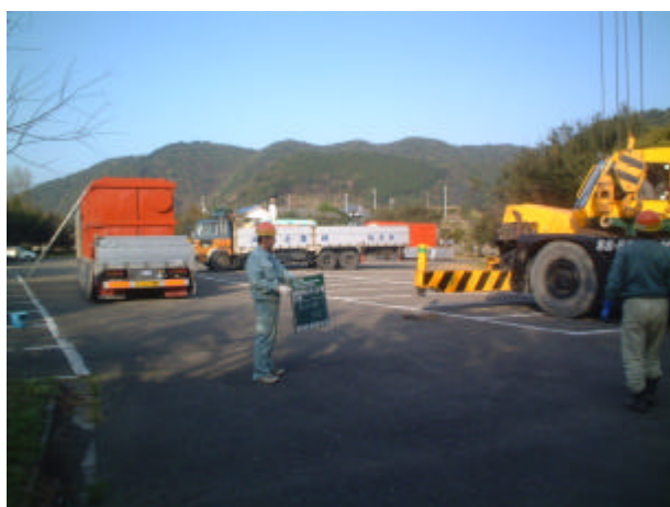
写真 3-8-3 仮設水槽搬入状況
