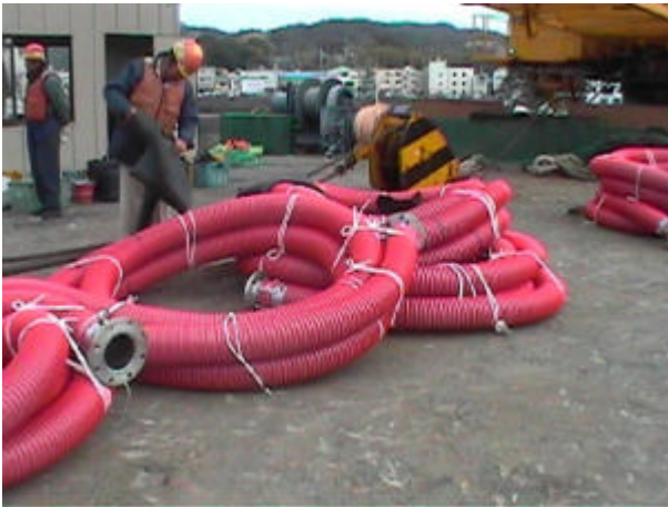
写真 2-4-11 仮設配管 (フレキシブルホース,6 インチ)
