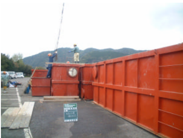
写真 3-8-15 仮設水槽撤去状況
