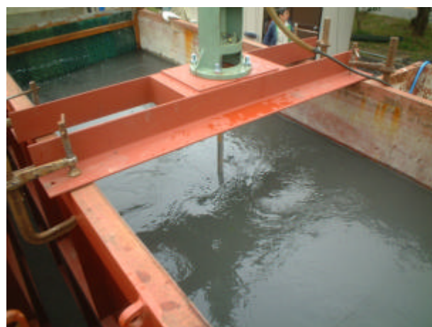
写真 3-5-22 攪拌機攪拌状況
