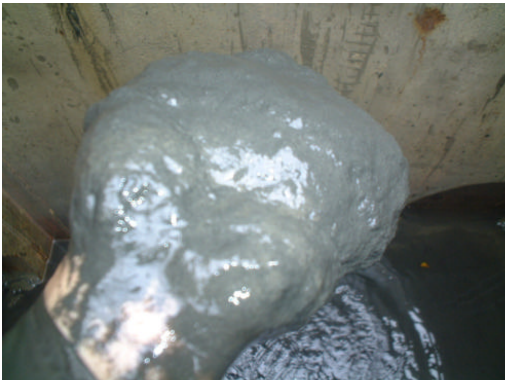
写真 2-3-24 水处理水槽堆積物（泥土）
