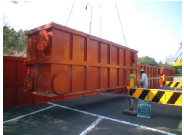
写真 3-8-6 仮設水槽設置状況
