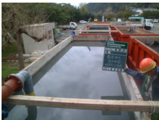
写真 3-5-9 浚渫排水の流入状況
