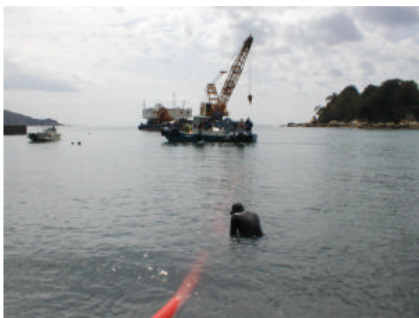
写真 2-4-20 仮設配管撤去状況
