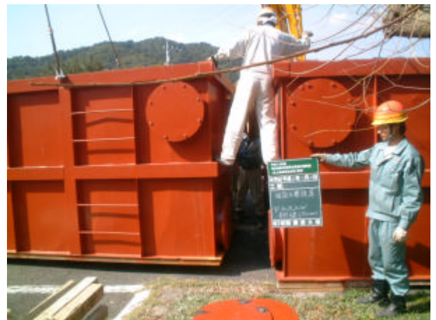
写真 3-8-8 仮設水槽設置状況
