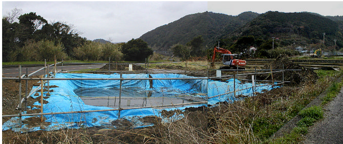
写真 1-5-4 土砂仮置き場
