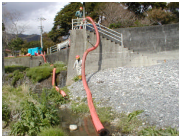
写真 2-4-9 仮設配管撤去状況
