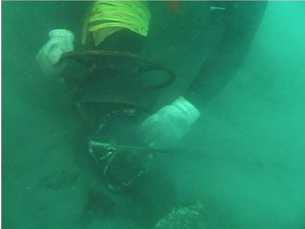
写真 2-3-29 浚渫状況（サンゴの死骸の排除）
