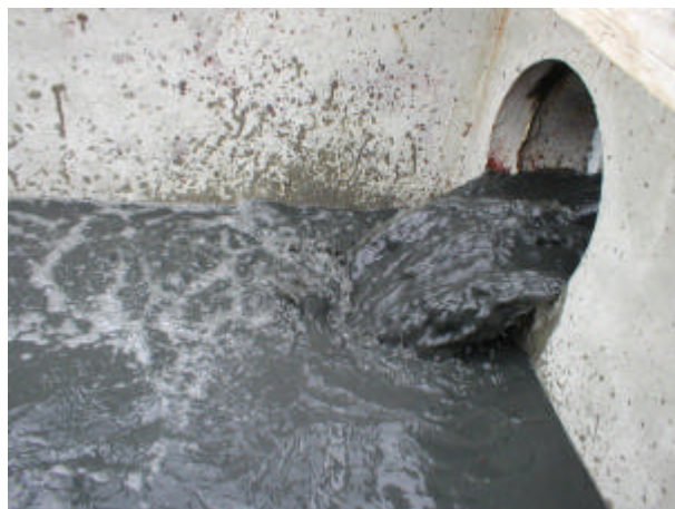
写真 3-5-8 浚渫排水の流入状況
