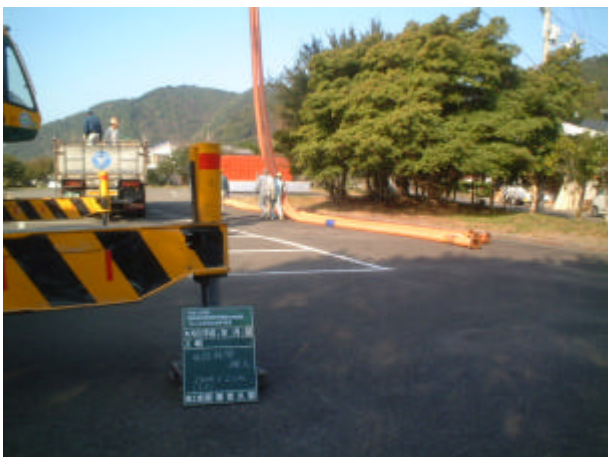
写真 2-4-3 仮設配管仮置き状況
