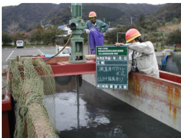
写真 3-5-21 攪拌機攪拌状況
