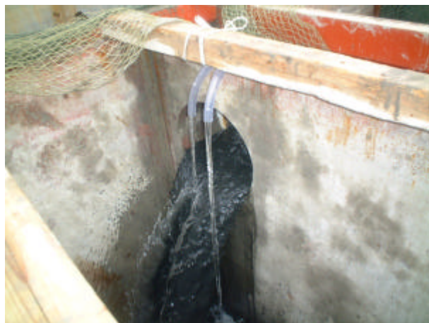
写真 3-5-18 高分子凝集剤注入状況
