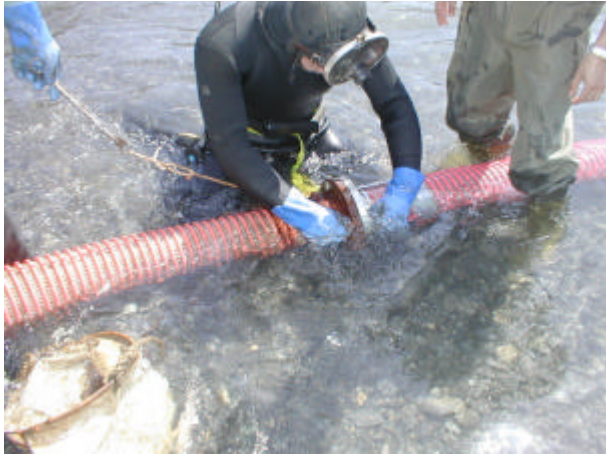
写真 2-4-16 仮設配管布設状況 (ジョイント部)
