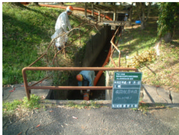
写真 2-4-4 仮設配管布設状況
