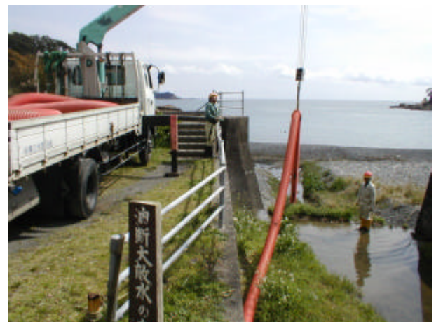
写真 2-4-10 仮設配管撤去状況
