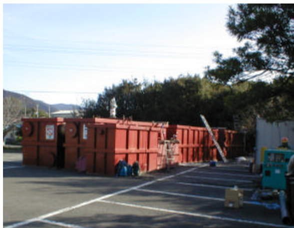
写真 3-5-1 仮設水槽設置状況
