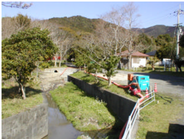
写真 2-4-7 仮設配管布設状況
