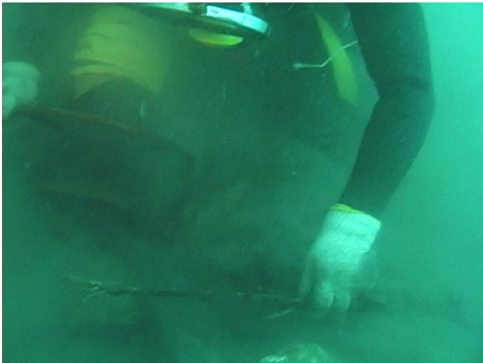
写真 2-3-30 浚渫状況（枝等の排除）
