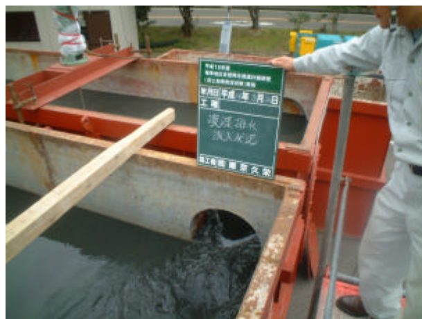
写真 3-5-10 浚渫排水の流入状況
