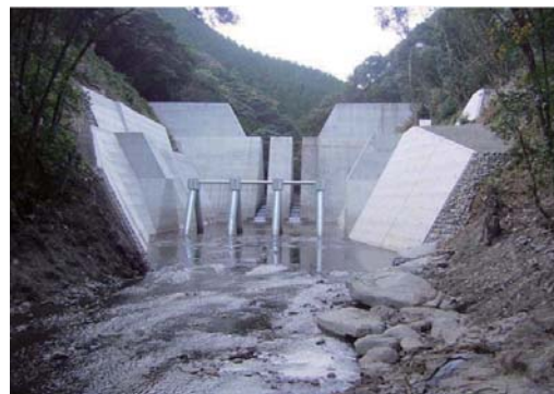
三崎川砂防ダム（H19年度完成）
